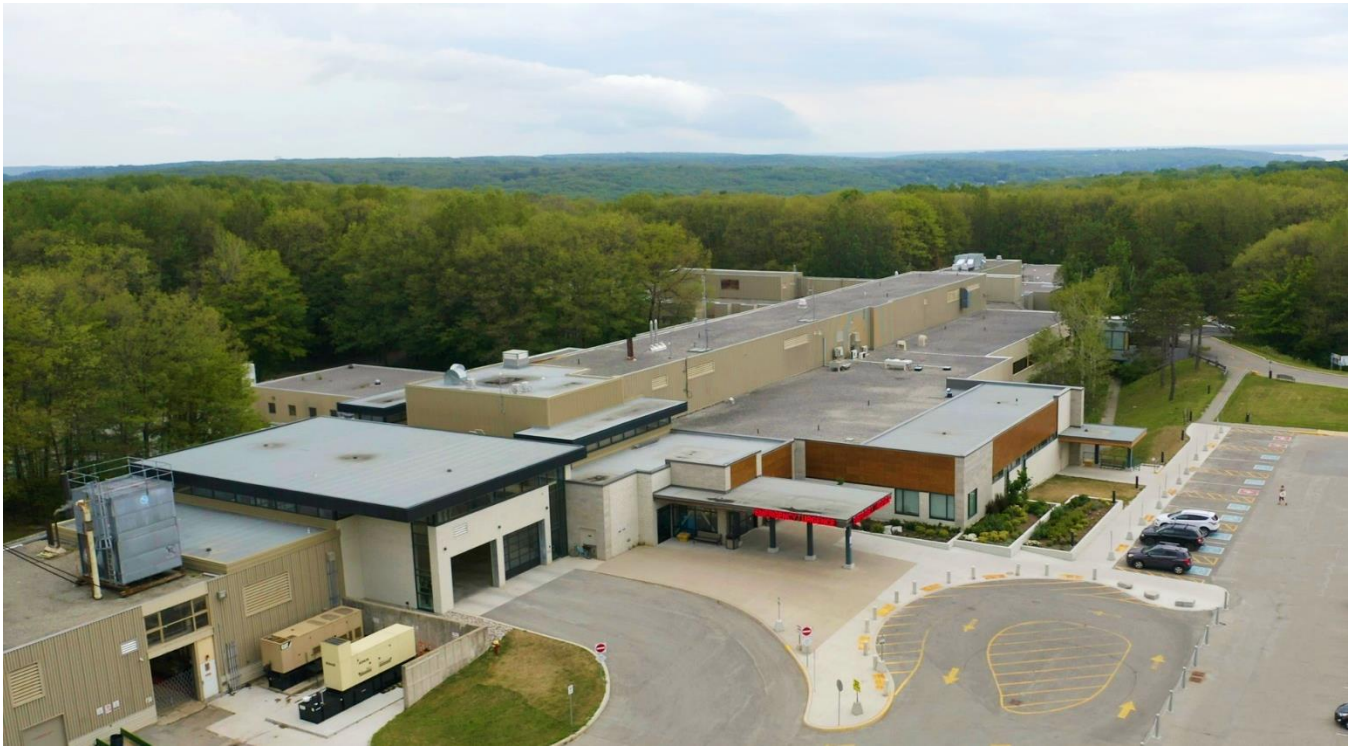
Figure 8. Photo aérienne de l'HGBG
